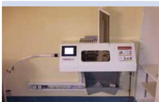
Die neue Rohrpoststation für die Notfallproben
