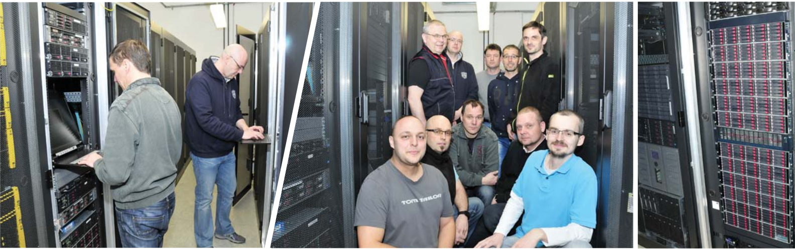
Torsten Dörn und Dirk Smoczyk im Serverraum
