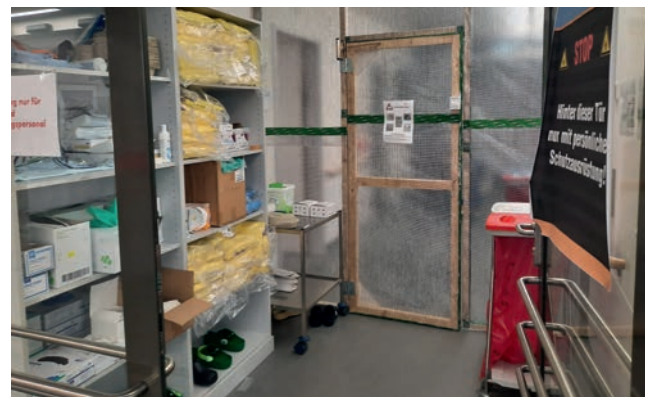
Provisorische Wände und Schleusen im Schwarzen Bereich
