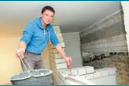
Martin Golembiowski von der Wolgaster Firma August Reiners mauert einen Lüftungsschacht für die Küche.
