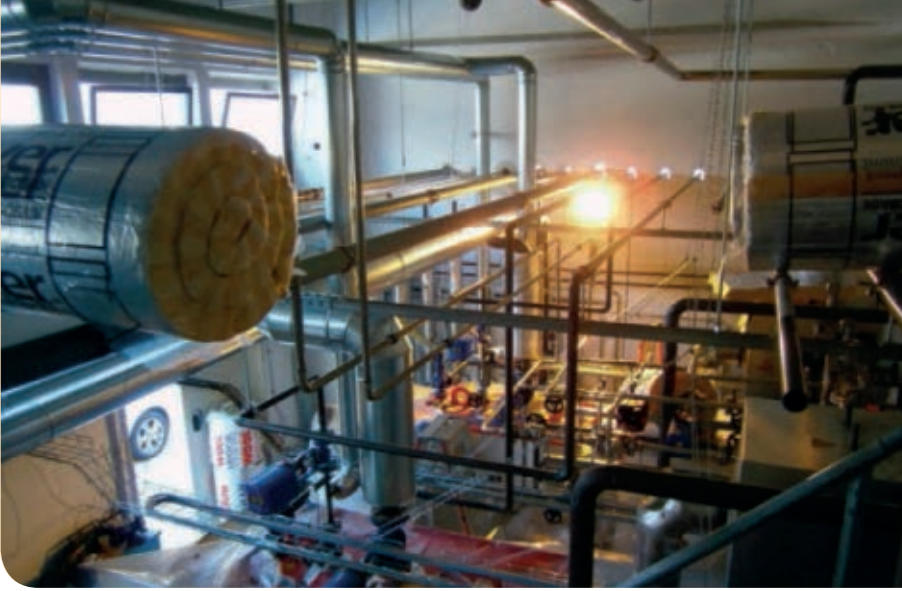
Blick auf die zwei neuen Dampfkessel während der Bautätigkeiten
