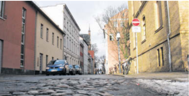
An manchen Stellen auf der Fahrbahn ist der Asphalt aufgeplatzt, das alte Natursteinpflaster guckt hervor. FOTO: SYBILLE MARX
